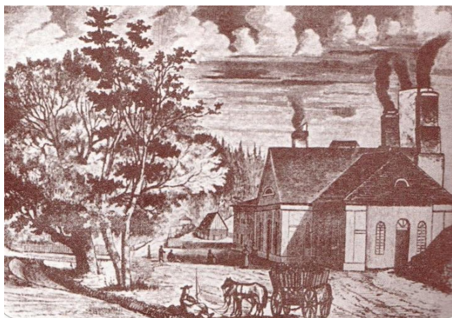
Valcovňa tyčového železa v Zlatne z roku 1861
